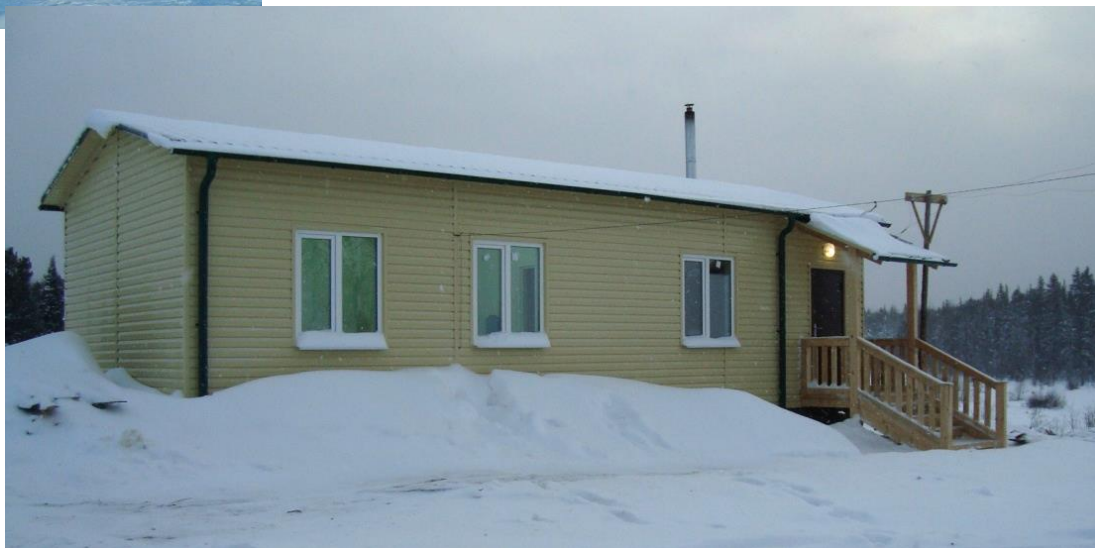
Фельшерско-акушерский пункт построенный из теплосберегающих SIP панелей в с. Верещагино Туруханского района
